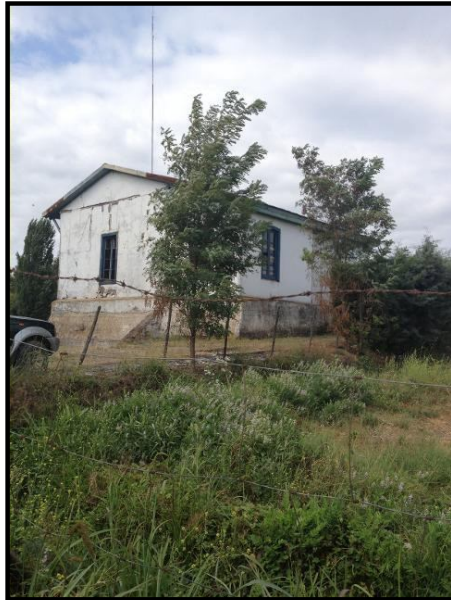
Fig. 1 PCH Dosal - Casa de Máquinas
