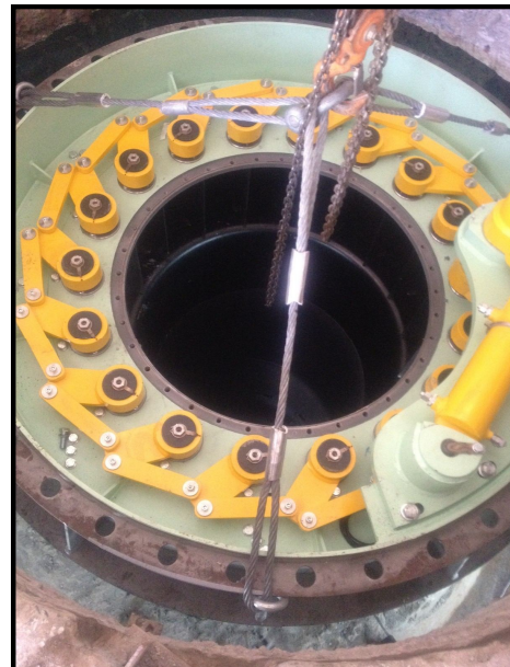
Fig. 2 PCH Los Morros - nueva turbina Kaplan
